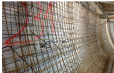
Silberbergtunnel Großbreitenbach, Germany
