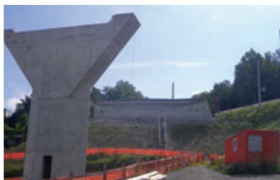
Ponte de la Poya Freibourg, Switzerland
